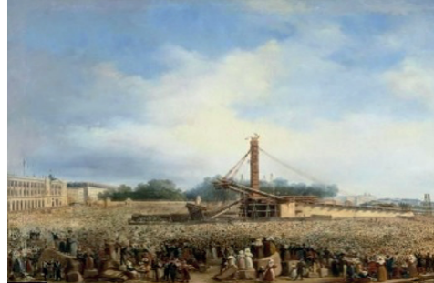
François Dubois, Erection de l'obélisque de Louxor le 25 octobre 1836
